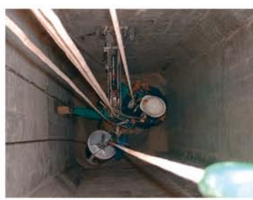
Limpieza y mantenimiento de silos
