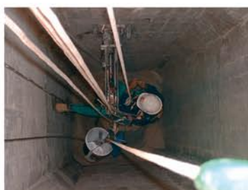
Limpieza y mantenimiento de silos
