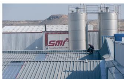
Líneas de vida y mantenimiento de cubiertas
