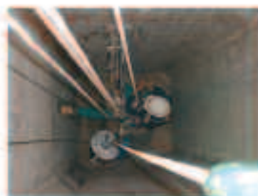
Limpieza y mantenimiento de silos
